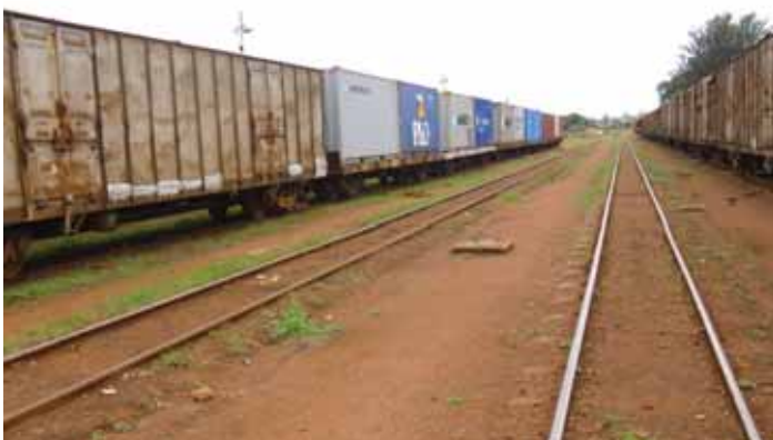
La infraestructura ferroviaria de Uganda es limitada, por lo que la mayoría de las mercancías se transportan por carretera (© flickr John Hanson – Ejército de los EE. UU.)
